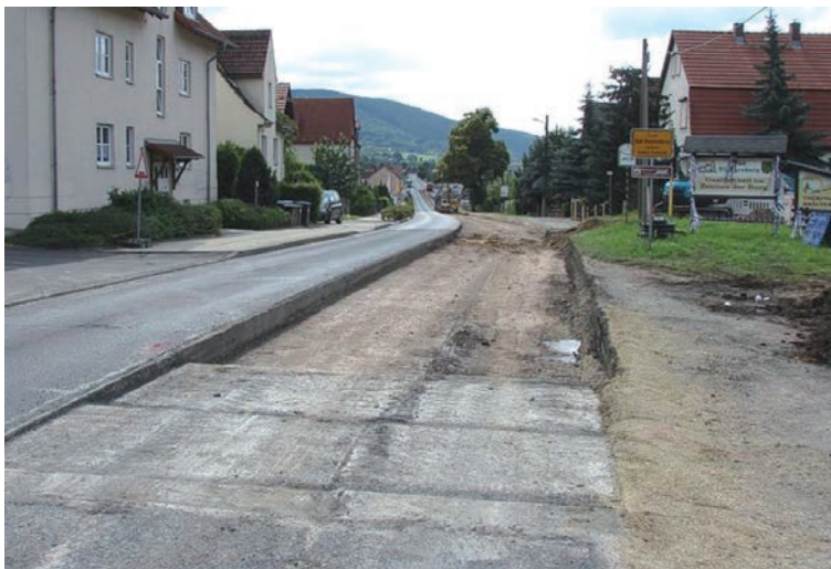
Bild: Ohne Worte (Fahrstreifen links wurde im Wechselverkehr lichtsignalgesteuert genutzt!) (Foto Korsch)
