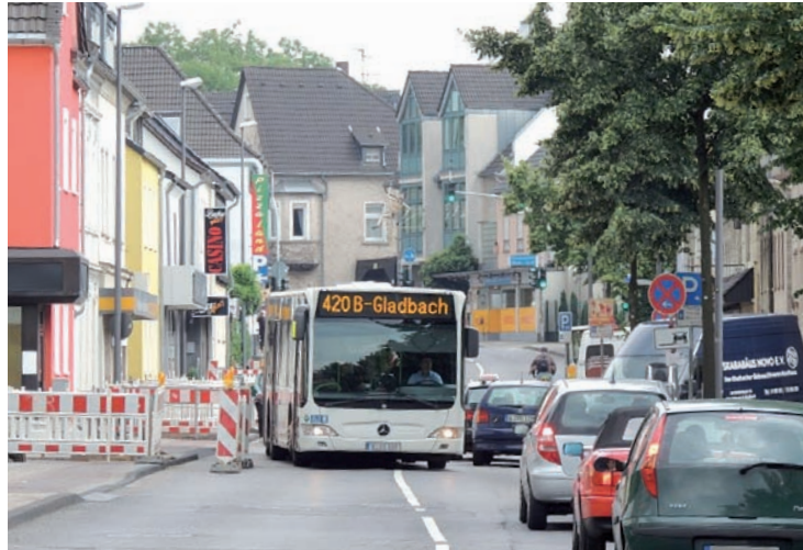
Bild 2: Verkehrsfährdung im Bereich der Fahrbahn (fehlende Markierung)
