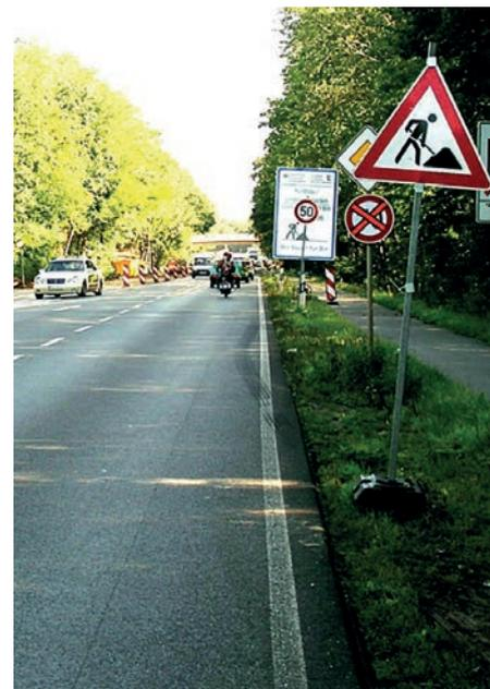
Bild 7: Unzulässig dicht am Verkehrsraum aufgestellte Verkehrsschilder außerorts
