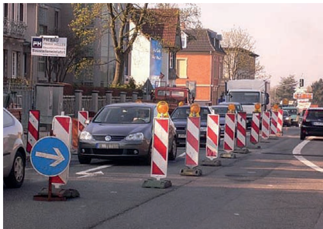
Bild 10: Falsche Anbringung von Zeichen 222
