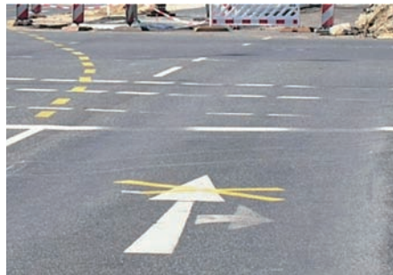
Bild 3: Pfeilmarkierung teilweise außer Kraft gesetzt
