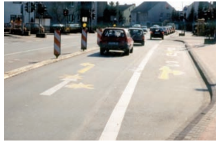
Bild 2: Pfeilmarkierung außer Kraft gesetzt und vorübergehend angeordnet
