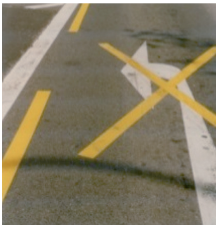
Bild 1: Korrekt ausgeführte vorübergehende Markierungen entsprechend StVO 2013
