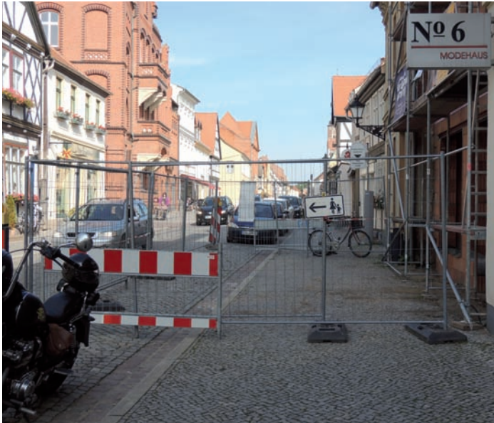
Bild 3: Fehlende Kennzeichnung im Fußgängerbereich (s. auch 1 )
