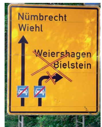
Bild 3: Falsche und richtige Änderung von Wegweisertafeln infolge einer Umleitung
