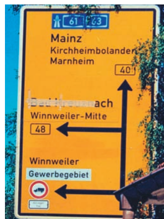
Bild 3: Falsche und richtige Änderung von Wegweisertafeln infolge einer Umleitung
