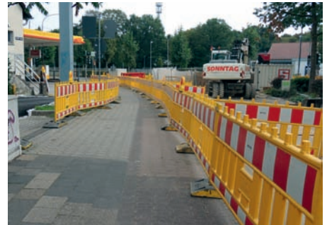
Bild 12 a und b: Korrekte Absperzungen eines Gehwegs mit Zeichen Absperrschranke jeweils zur Gehwegseite
