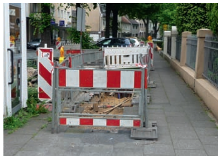
Bild 12 a und b: Korrekte Absperzungen eines Gehwegs mit Zeichen Absperrschranke jeweils zur Gehwegseite
