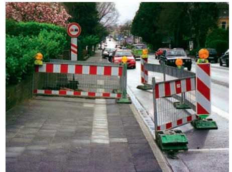
Bild 16: Korrekte Sicherung eines Fußgänger-Notgehwegs über die Fahrbahn
