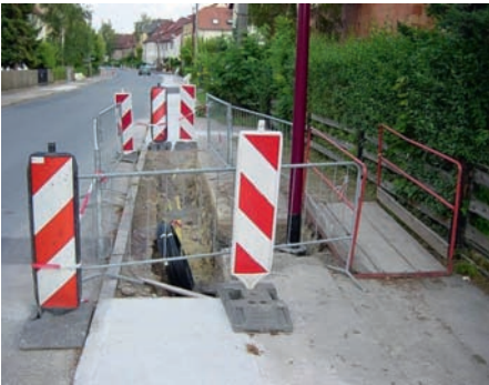
Bild 19: Leitbaken im Bereich einer Behelfsbrücke (Bild Korsch)
