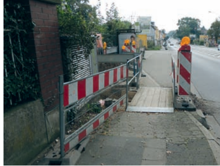
Bild 18: Behelfsbrücke für Fußgänger gemäß ZTV-SA
