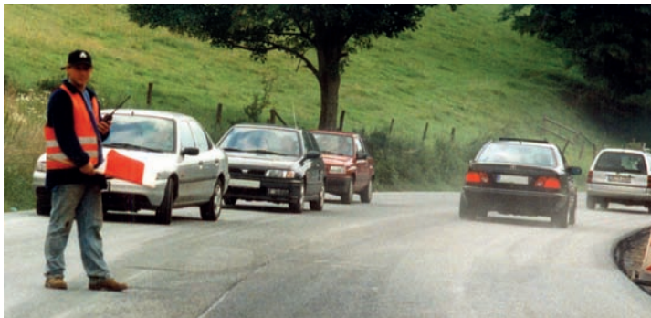
Bild 10: Unzulässige Verkehrsregelung durch Signalposten
