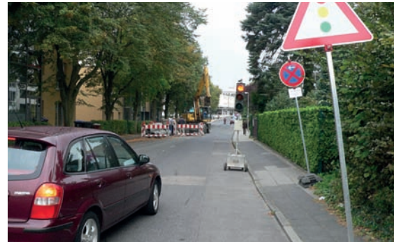
Bild 9: Überflüssige Lichtsignalregelung an einer übersichtlichen Einengung einer Wohnstraße
