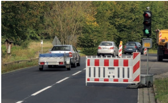
Bild 8: Lichtsignalregelung wegen langer einspuriger Einengung
