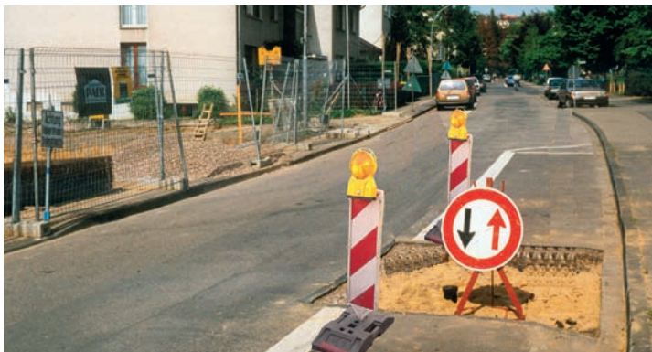
Bild 12: Überflüssiges Zeichen 208 als Ersatz für Absperrung
