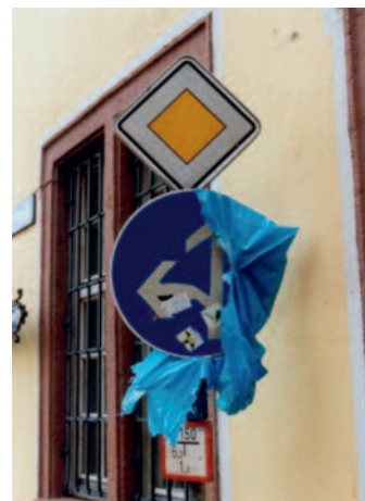
Bild 3: Nicht wiederhergestellte oder nach dem Abbau vergessene Abdeckung
