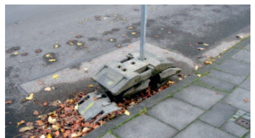
Bild 6: Fehlende Standsicherheit
