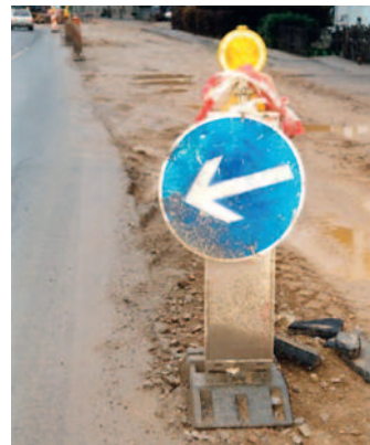
Bilder 8 und 9: Keine qualifizierte Absicherung und fehlende Erkennbarkeit insbesondere bei Nacht
