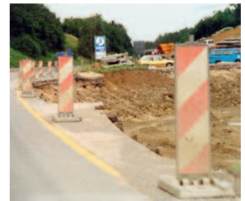
Bilder 8 und 9: Keine qualifizierte Absicherung und fehlende Erkennbarkeit insbesondere bei Nacht
