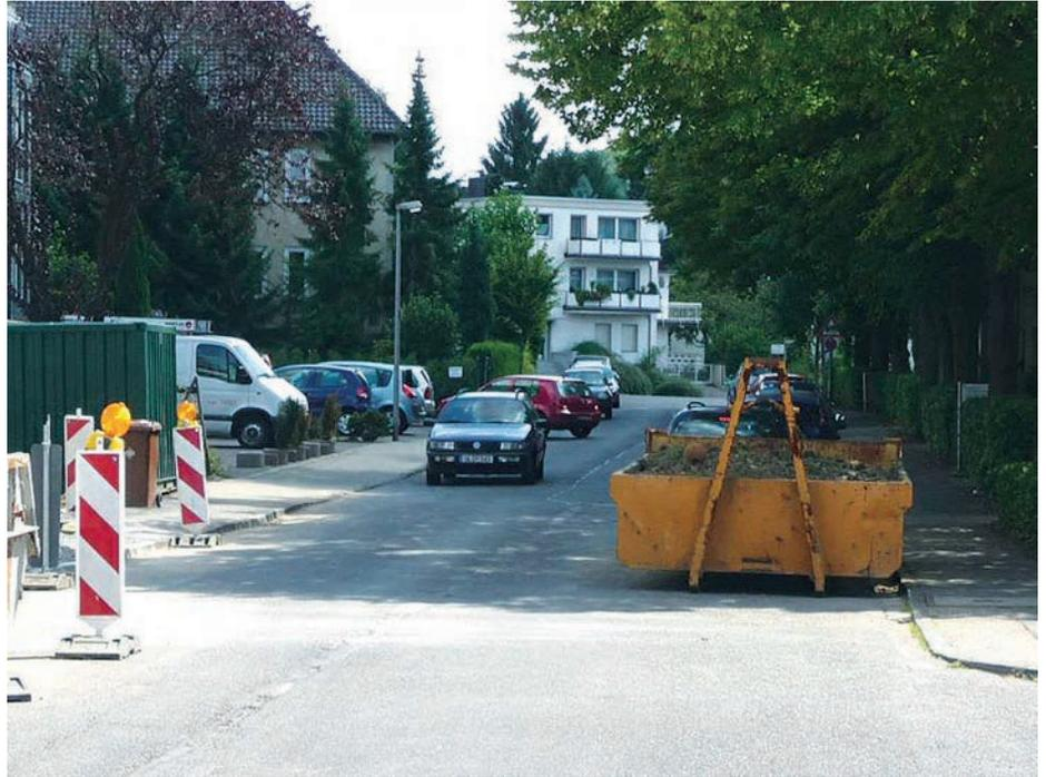
Bild 4: Erhebliche Gefahr durch fehlende Kennzeichnung und Beleuchtung des Containers
