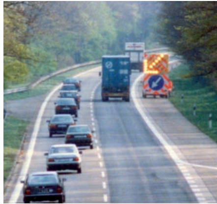
Bild 5: Sicherung einer Arbeitsstelle auf dem Seitenstreifen einer Autobahn mit Zeichen 616 (links: korrekt mit Blinkkreuz, rechts: falsch mit Blinkpfeil)
