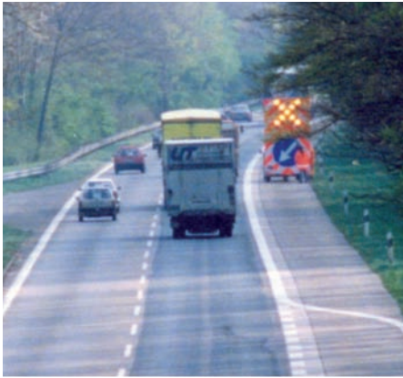
Bild 5: Sicherung einer Arbeitsstelle auf dem Seitenstreifen einer Autobahn mit Zeichen 616 (links: korrekt mit Blinkkreuz, rechts: falsch mit Blinkpfeil)
