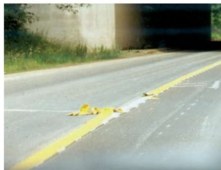
Bild 17: Beginnende Auflösung einer vorübergehenden Markierung
