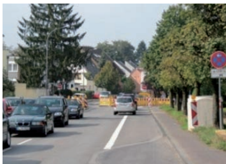
Bild 13: Fehlende Längsmarkierung zur Trennung vom Gegenverkehr (links) 1 bzw. fehlende Führung des Behelfsfahrestreifens (rechts) 2
