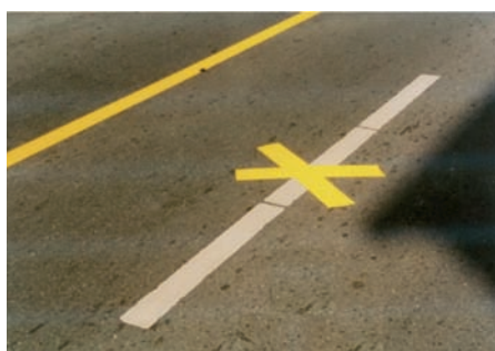
Bild 15: Überflüssige gelbe Kreuzmarkierungen
