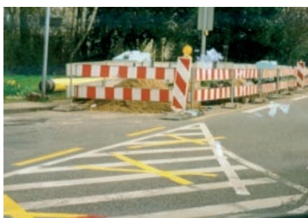
Bild 13: Fehlende Längsmarkierung zur Trennung vom Gegenverkehr (links) 1 bzw. fehlende Führung des Behelfsfahrestreifens (rechts) 2
