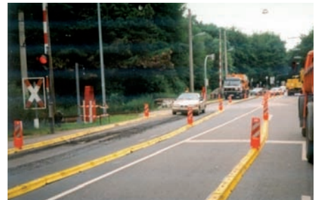
Bild 9: Längsmarkierung mit Leitschwellen innerorts
