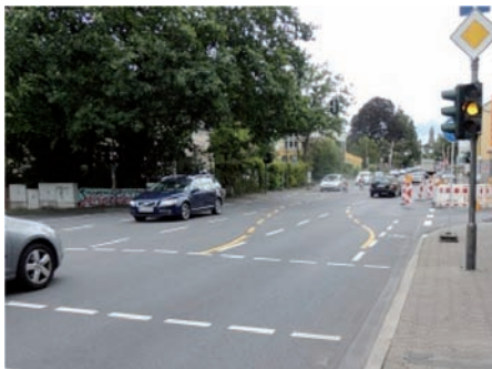
Bild 6: Vorübergehende Randmarkierung (Verlegung des Fahrbahnrandes ohne Leitbaken)
