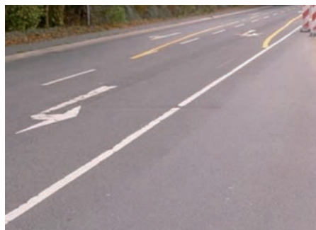
Bild 13: Fehlende Längsmarkierung zur Trennung vom Gegenverkehr (links) 1 bzw. fehlende Führung des Behelfsfahrestreifens (rechts) 2
