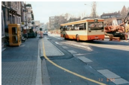
Bild 7: Randmarkierung führt über Gehweg (keine Leitbaken vorhanden)
