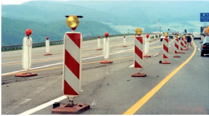
Bild 6: Korrekte Anwendung einseitiger Leitbaken
