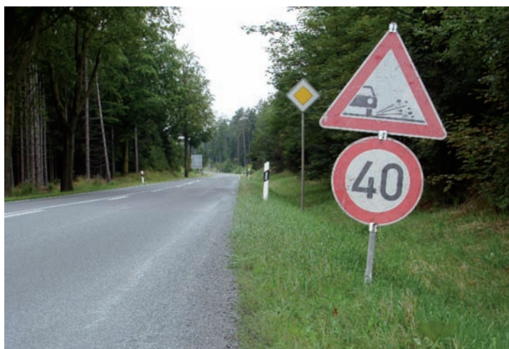
Bild 1: Ordnungsmäßig beschilderte Strecke mit Rollsplitt (Bilder: 1 und 3 bis 5: Korsch)
