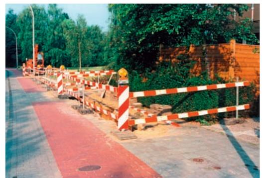
Bild 1: Absperrung im Fahrzeug-Verkehrsraum (links) sowie Fuß- und Gehwegbereich (rechts)
