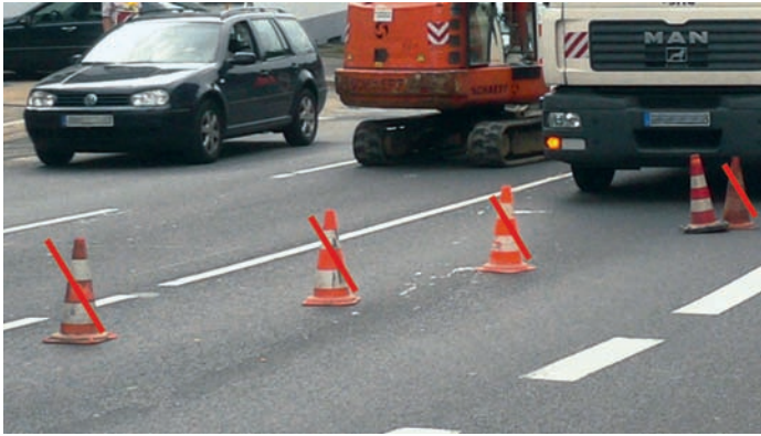
Bild 5: Querabspernung mit Auswahl von zulässigen und unzulässigen Leitkegeln
