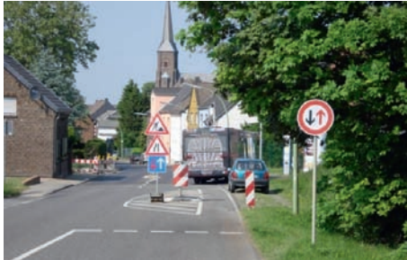
Bild 10: Fehlende Abdeckung der vorhandenen Beschilderung [Korsch]
