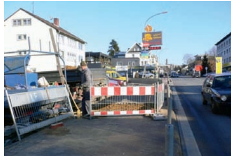
Bild 2 und 3: Baustelle auf der Grundlage des Verkehrszeichenplans in Bild 1 (falsche und fehlende Absperrung, Verkehr muss durchgezogene Linie überqueren)
