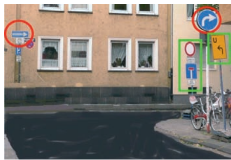
Bild 5: Fehlende Abdeckung vorhandener Verkehrszeichen
