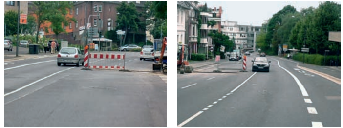
Bild 2 und 3: Baustelle auf der Grundlage des Verkehrszeichenplans in Bild 1 (falsche und fehlende Absperrung, Verkehr muss durchgezogene Linie überqueren)
