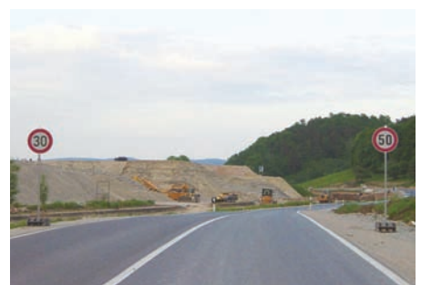
Bild 4: Widersprüchliche beidseitige Aufstellung (Foto: Korsch)
