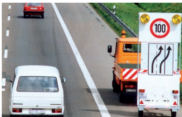
Bild 9: Überleitung auf den Seitenstreifen 4
