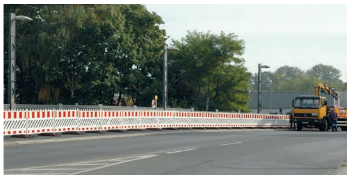
Beide Kunststoff-Absturzsicherungen „PRO“ und „FLEX“ entsprechen den Vorschriften der ZTV-SA
