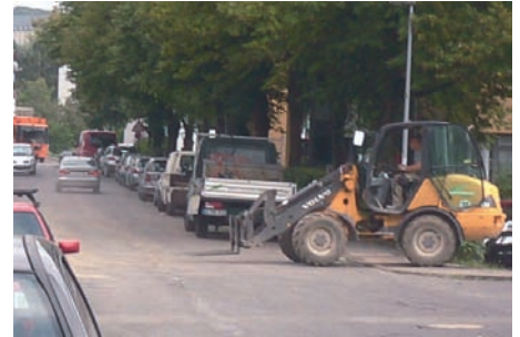
Bild 5: Der Einsatz des Gabelstaplers setzt hier Sonderrechte voraus und ist daher ohne Warnkennzeichnung unzulässig
