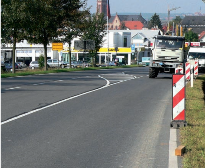
Bild 6a, b: Fehlende Markierungen und Rundumlichter an Baufahrzeugen und Arbeitsmaschine wie bei Bild 5
