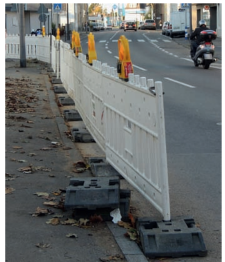
Bild 5: Warnleuchten in sinnloser Anordnung parallel zur Sichtrichtung
