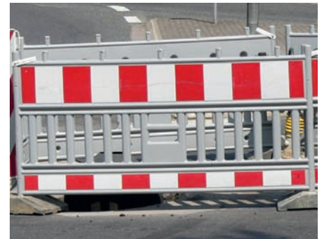
Bild 3: Korrekte Abspernung mit sogenannter mobiler Absturzsicherung
