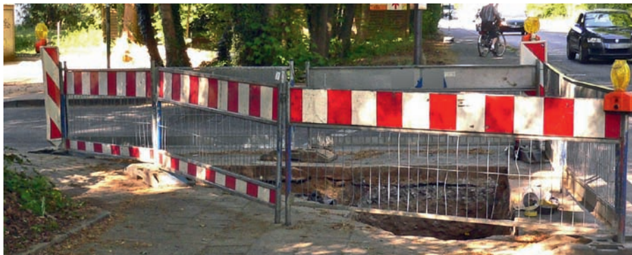
Bild 2: Abspernung gemäß RSA 95
