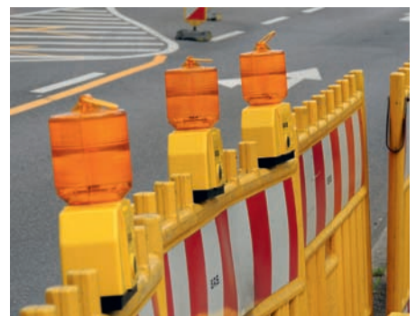
Bild 6: Für Absperrungen im Gehwegbereich empfehlenswerter: Rundstrahler
