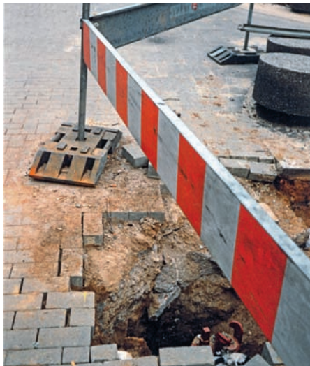
Bild 8: Fahrlässige Anordnung einer Absperrung in einer Fußgängerzone
