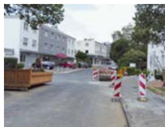
Bild 4: Fußgänger werden nicht geführt und nur durch Leitbaken statt durch Absperrschranken am Betreten der Arbeitsstelle gehindert
