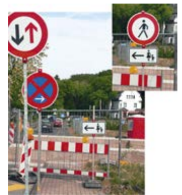
Bild 9: Unvollständiger Hinweis für Fußgänger: Ein Zusatzzeichen allein kann nicht angeordnet werden (korrekt: kleines Bild oben)
