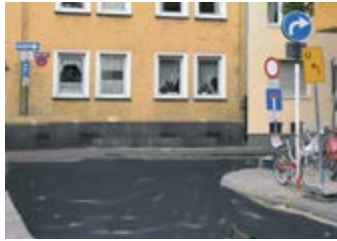
Bild 11: Sperrung einer Straße mit angekündigter Umleitung, die aber wegen der nicht entfernten/abgedeckten ständigen Verkehrszeichen nicht genutzt werden kann
