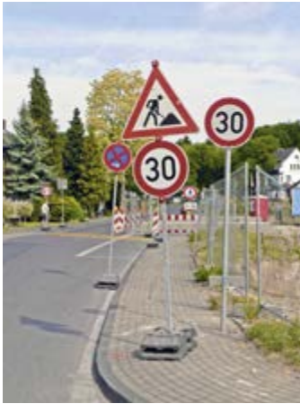
Bild 5: Angeordnete Geschwindigkeitsbeschränkung, die jedoch schon dauerhaft vorhanden ist
